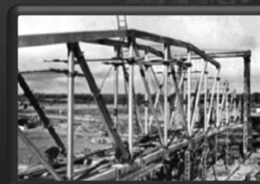
1950 r. - pierwszy klejony most stalowy nad kanałem Lippe- Seiten koło Marl w Niemczech
