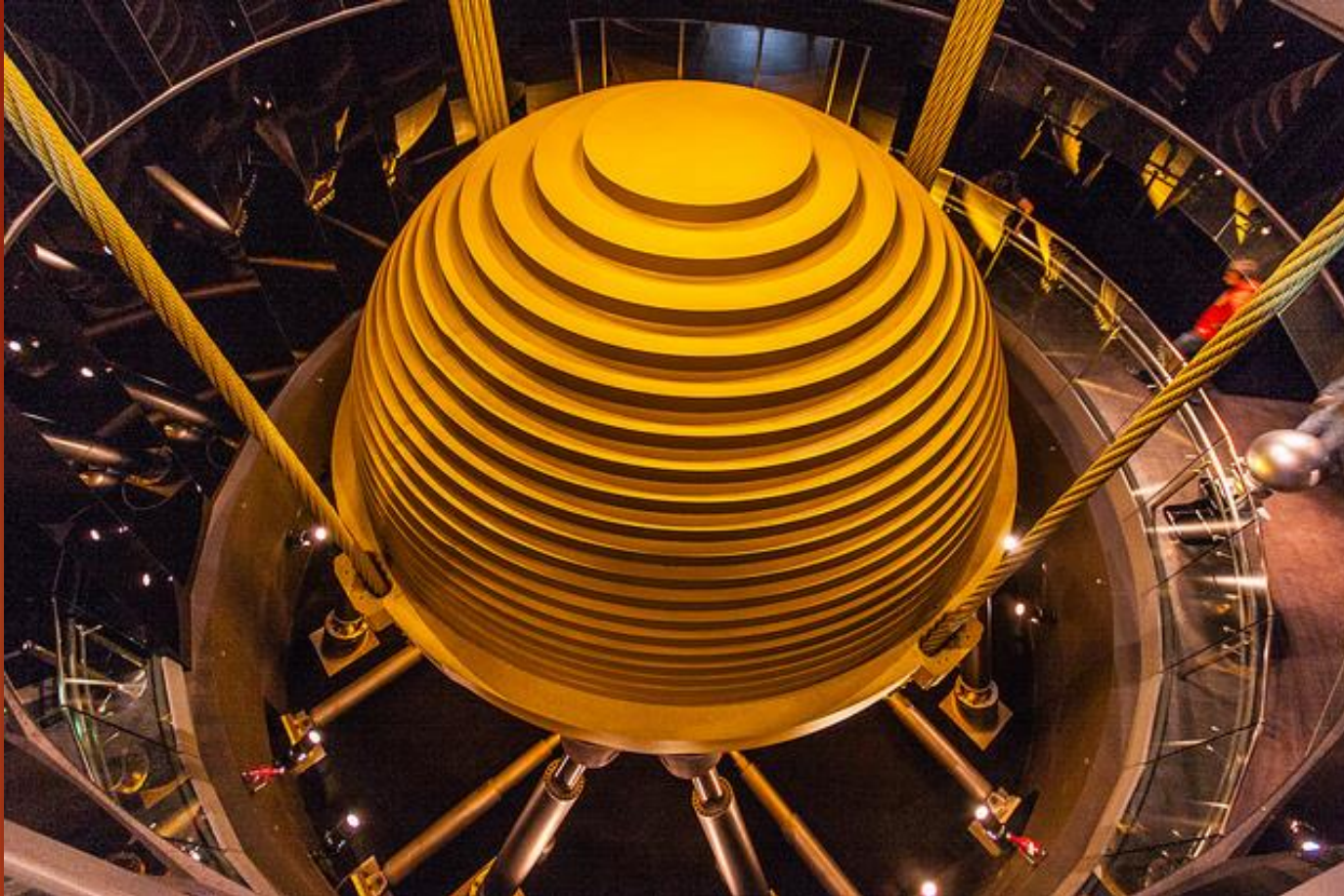
Tuned Mass Damper zastosowany w wieżowcu Taipei 101 (masa: 660 ton)
