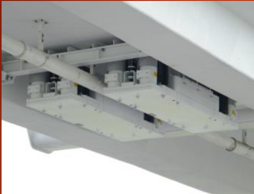
Wibroizolacja kładki dla pieszych (Malta – Poznań)
