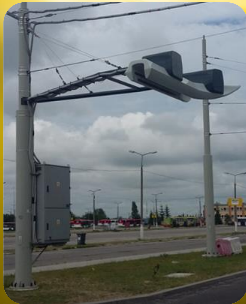
Stacja ładowania przez pantograf
